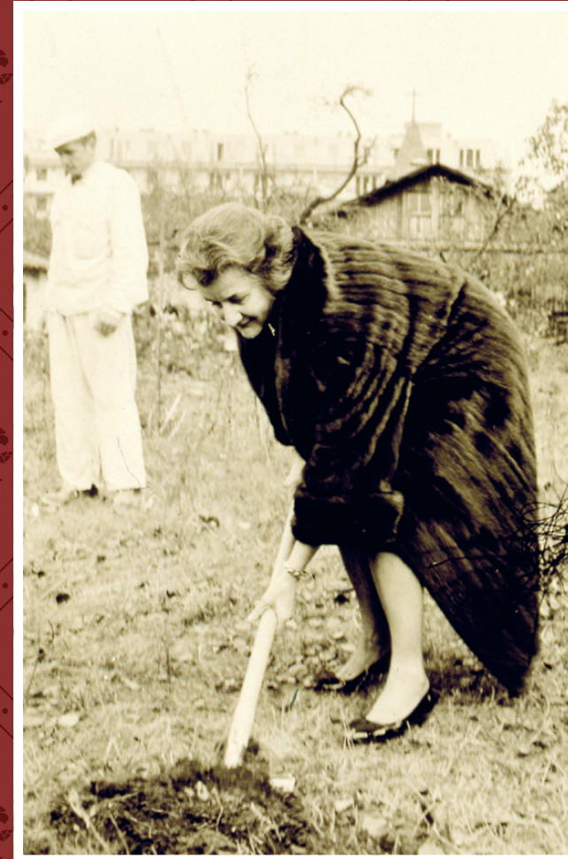
Wiederaufbau nach dem Krieg: Martina Hörbiger beim Spatenstich zum Bau des neuen Verwaltungsgebäudes in Wien-Simmering (1949).
