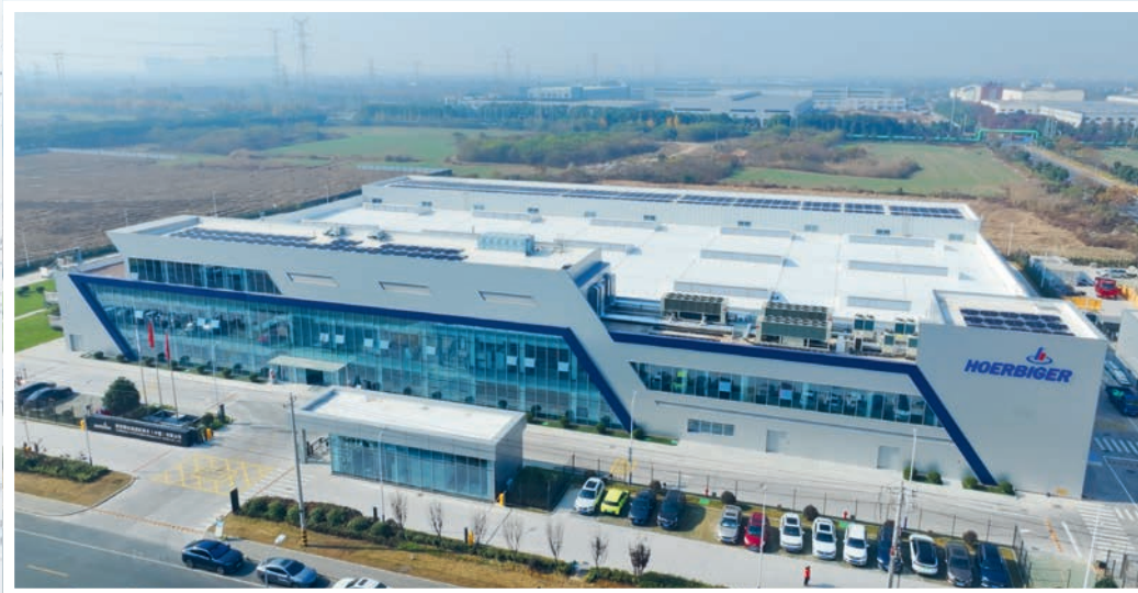
Nach nur einjähriger Planungs- und Bauzeit wurde am 12. Dezember 2023 das neue HOERBIGER Werk in Changzhou, China eröffnet.
