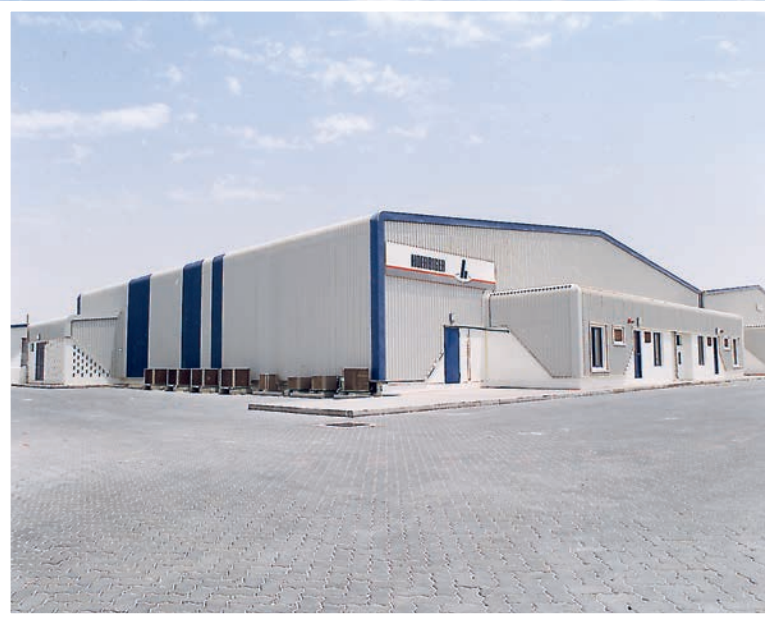
HOERBIGER Niederlassung in Dubai vor dem Neubau in der Jebel Ali Free Zone, späte 1990er Jahre.
