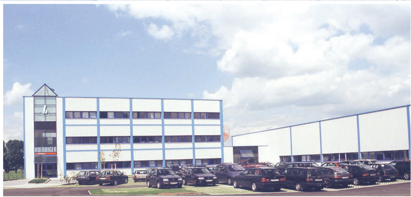
HOERBIGER Origa Systems GmbH, Altenstadt, Deutschland, frühe 2000er Jahre. Heute befindet sich in dem Gebäude die HOERBIGER Flow Control GmbH.
